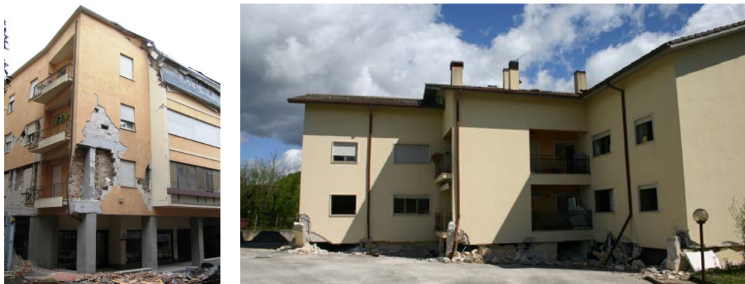
Exemplos de edifícios danificados no sismo de Áquila (Itália) em 2009.
